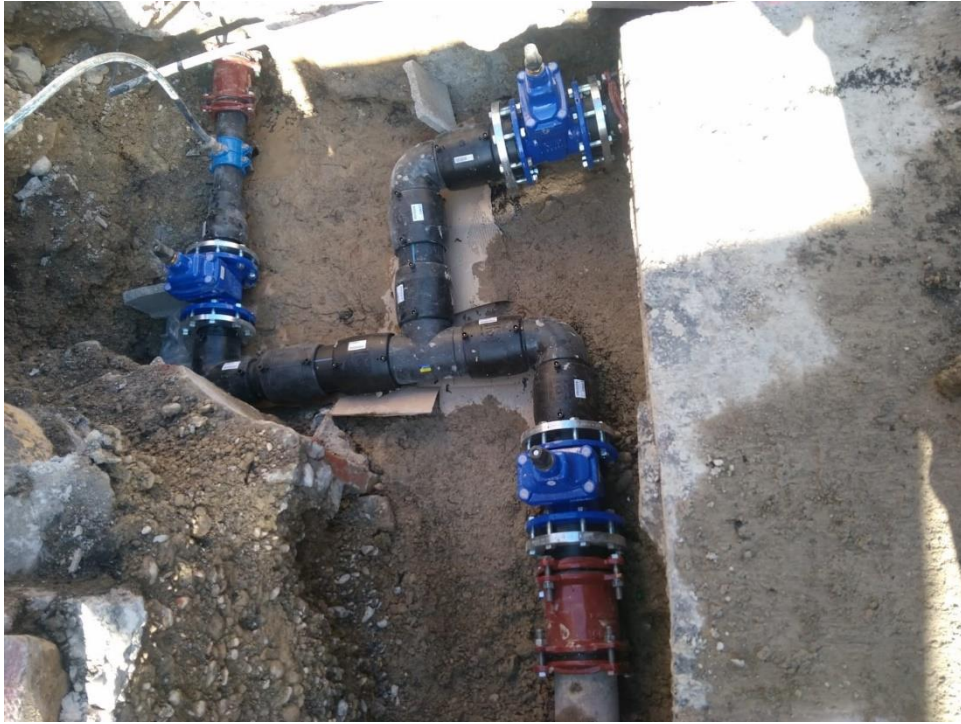
Estat final amb les 3 noves vàlvules de comporta elàstica
